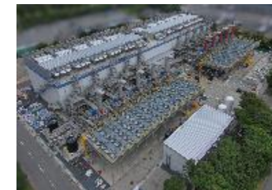
建設中の袖ヶ浦ガスエンジン
