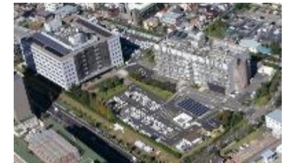
東京ガス千住テクノステーション
