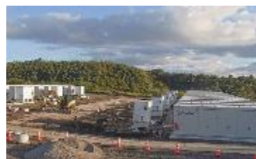
角子原パワーストレージステーション (建設中)
