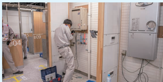
風呂給湯器施工訓練
