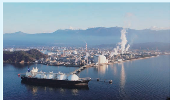
新居浜LNG基地とLNG船
