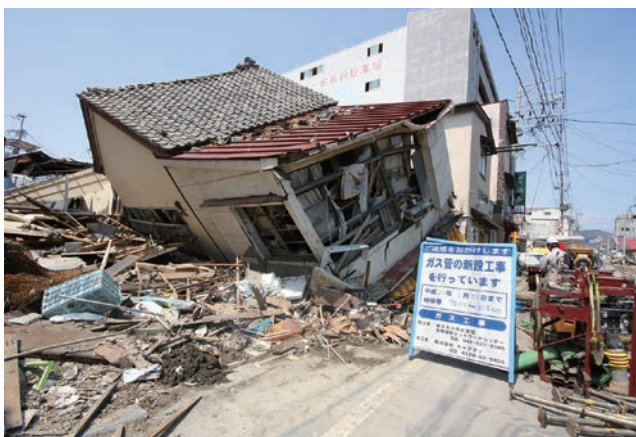
倒壊した家屋や瓦礫の横で進められた復旧作業（石巻地区）
