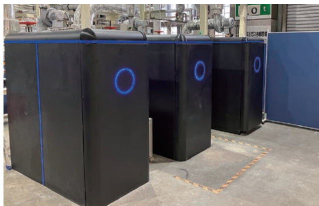
カナダのCleanO2社製の二酸化炭素回収装置「CarbinX™」
