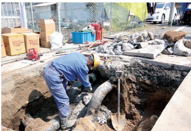
川をまたいで敷設されている本支管の修繕作業（いわき地区）
