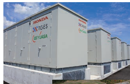
Hondaに導入したリチウムイオン蓄電池
