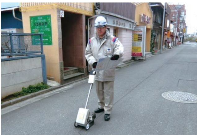
漏洩検査を行う復旧隊員（土浦地区）
