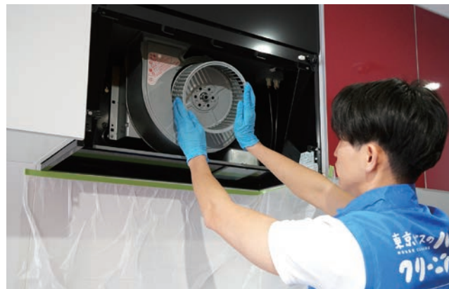
レンジフードを清掃するスタッフ
