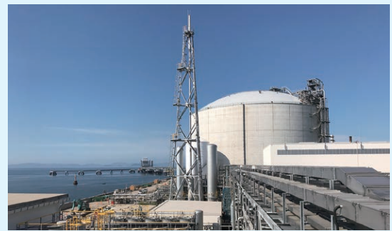
新居浜LNG基地(2022年3月稼働)
