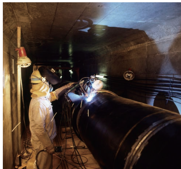
京浜幹線の建設 (1999 年開通)
