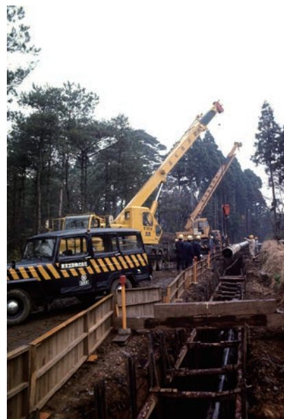
環状パイプラインの敷設（1975年完成）
