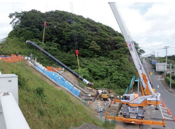
道路のり面への配管工事。短工期の完成を目指し、これまで1本あたり12mだった導管の長さを12.4mに伸ばす工夫をした
