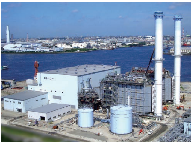
扇島パワーステーション。手前側の煙突と付随した設備が 1 号機
