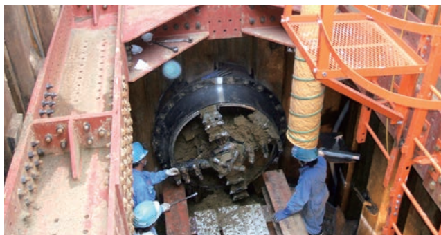
千葉～鹿島ライン幹線工事（2012年3月完成）
