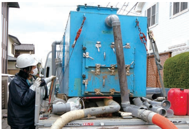
管の中に入り込んだ水をバキュームカーで吸い出す作業（浦安地区）
