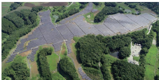
市貝太陽光発電所（2023年7月商業運転開始）
