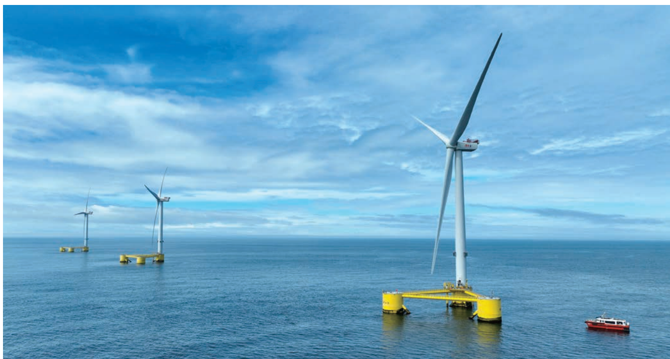
ポルトガルの浮体式洋上風力発電へ参画（2024年8月） 提供：オーシャン・ウインズ社、プリンシプル・パワー社
