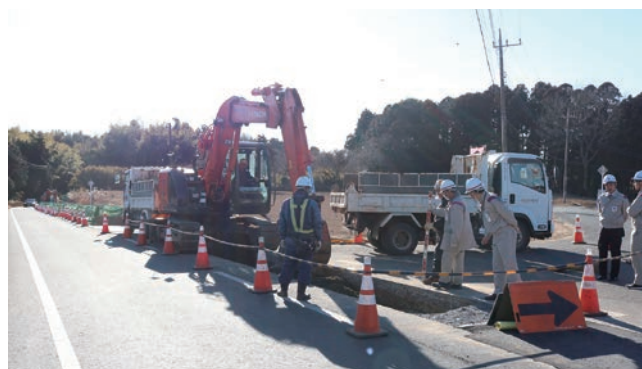
茨城幹線の敷設工事
