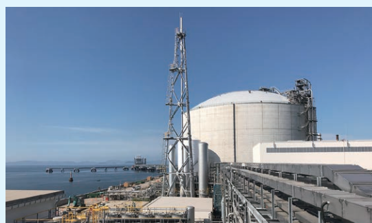
新居浜LNG基地(2022年3月稼働)
