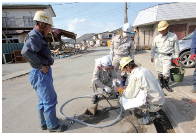
東日本大震災での復旧活動ヘルメットには「がんばろう！日本」の文字が貼られていた（2011年3月～5月）
