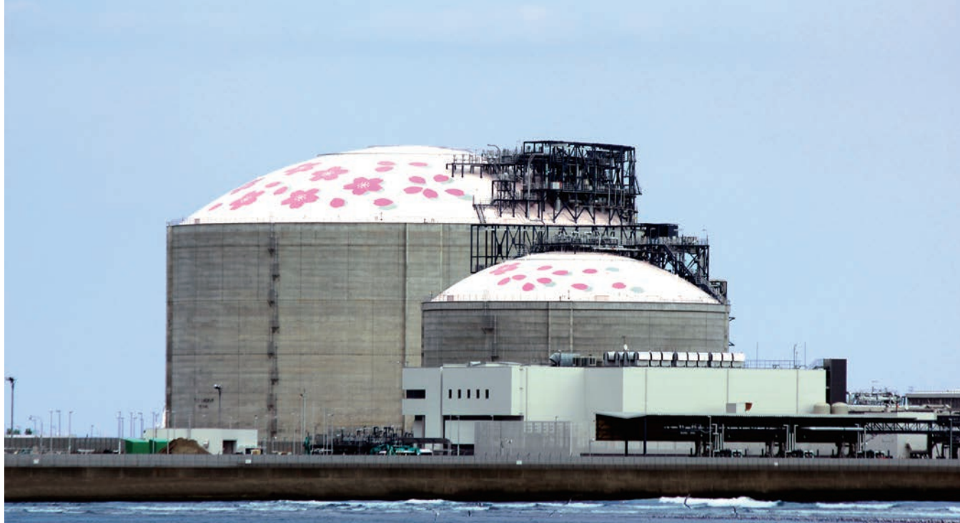
初めて東京湾外に建設した日立 LNG 基地（2016 年 3 月操業開始）
