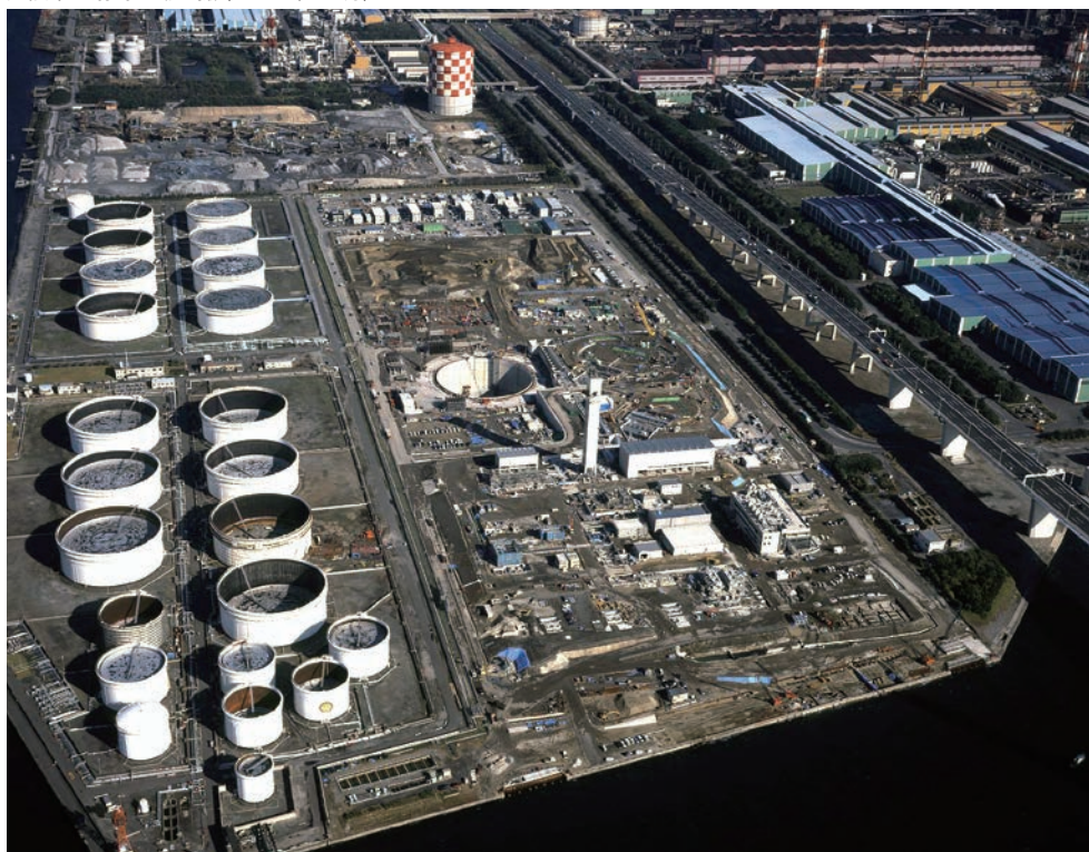
建設中の扇島工場空撮（1997年11月）
