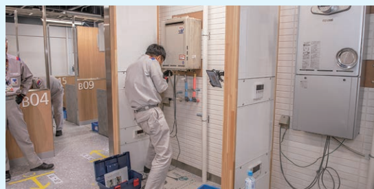
風呂給湯器施工訓練
