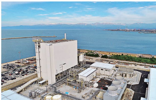
伏木万葉埠頭バイオマス発電所 (2022 年 7 月商業運転開始)
