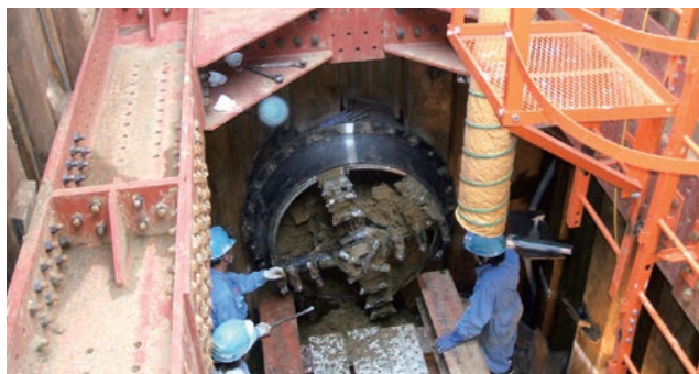
千葉～鹿島ライン幹線工事（2012年3月完成）
