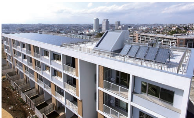
当社の社宅として建設された東京ガス磯子スマートハウスで集合住宅版スマートハウス実証試験を行った（2012 年 4 月）
