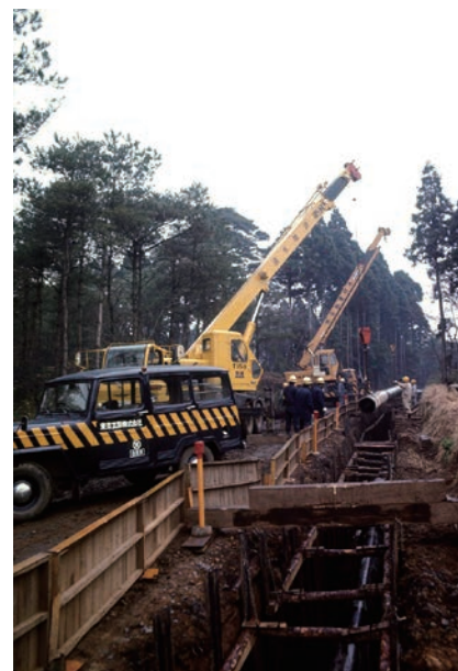
環状パイプラインの敷設（1975年完成）
