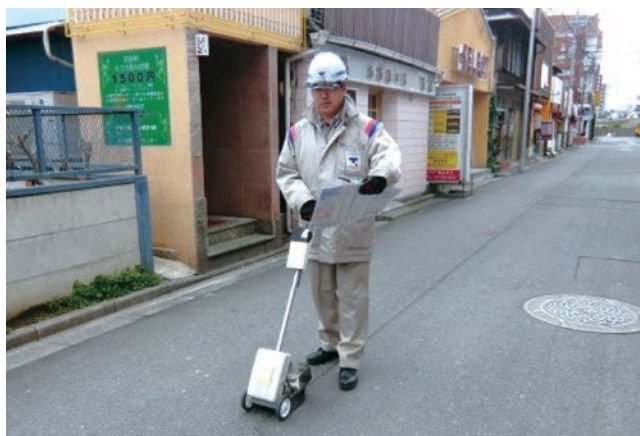
漏洩検査を行う復旧隊員（土浦地区）
