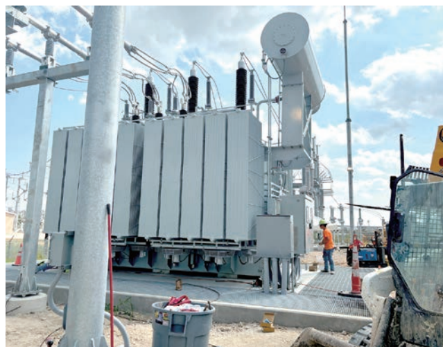
テキサス州で展開しているロングボウ蓄電池事業
