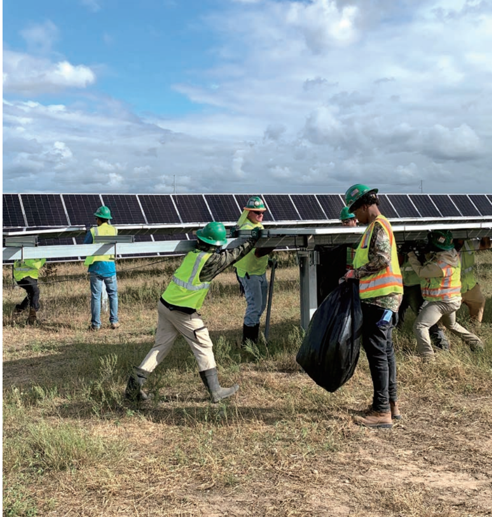
アクティナ太陽光発電所パネル設置の様子
