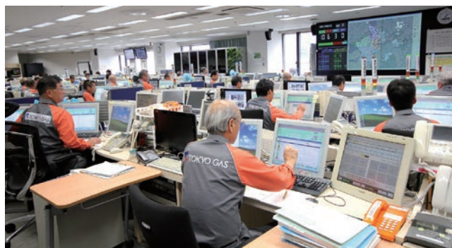
震災後、最も重要視されたのはお客さまからの問い合わせ対応。保安指令センターが漏洩に特化した対応を取れるように体制を改善した
