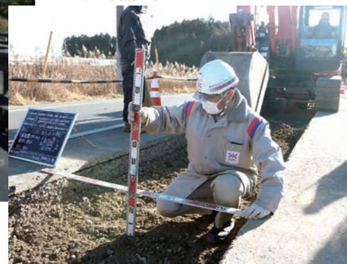
開削工事は掘削・配管、溶接、埋め戻しの作業に分かれて進められた。写真は銚田北工区の開削工事
