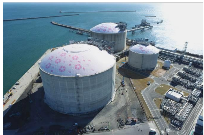
Aerial Photograph of Hitachi LNG Terminal
