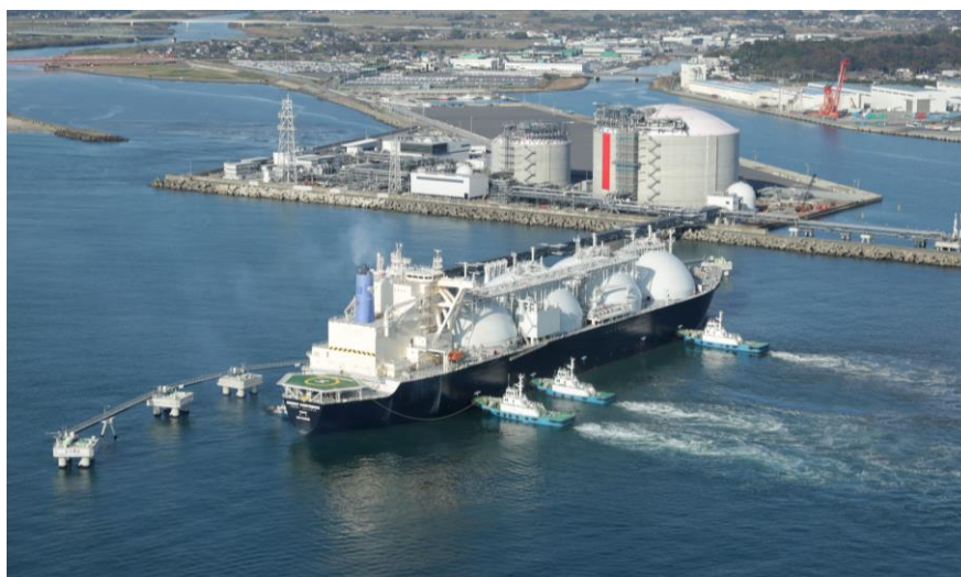
Hitachi LNG Terminal
