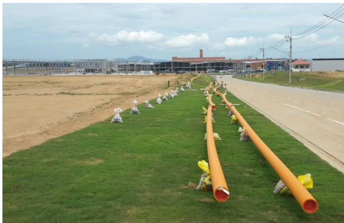
＜タイ工業団地向け導管敷設工事状況＞
