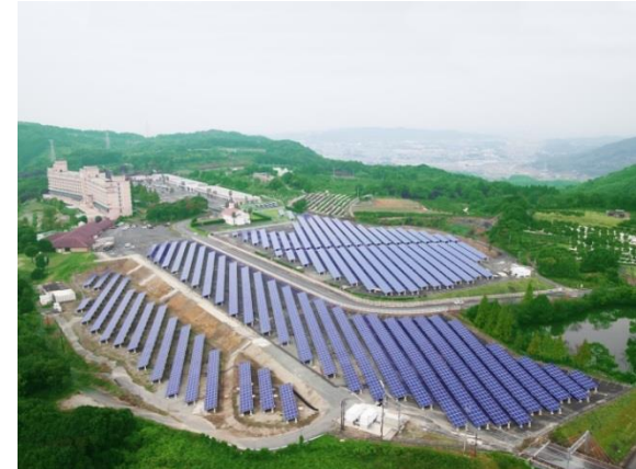
<熊本県南関町 太陽光発電所>
