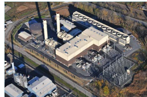
<エンパイア発電所> (2016年10月)
