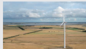
トービー・リニューアブルズ社所有の風力発電所 [Vognkær (ボウンケアー)]
