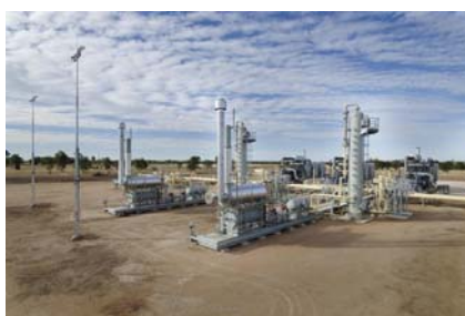
クイーンズランド・カーティス LNGプロジェクト (CBMガス処理プラント)
