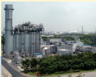
東京ガスベイパワー発電所(千葉県袖ヶ浦市) (発電能力: 10万kW)
