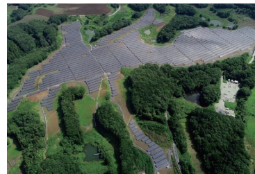
市貝太陽光発電所
