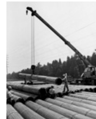
千葉幹線工事
