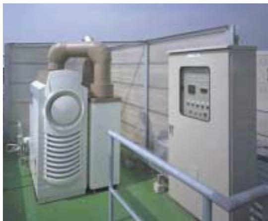
中原ビルで実証試験運転中のマイクロタービンコージェネレーション
