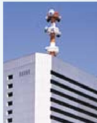
東京ガス本社ビル屋上に設置されたアンテナは、防災・供給センターと工場、整圧所、導管ネットワークセンターなどを無線通信回線で結んでいます
