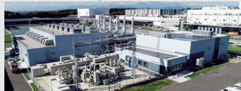
清原スマートエネルギーセンター
