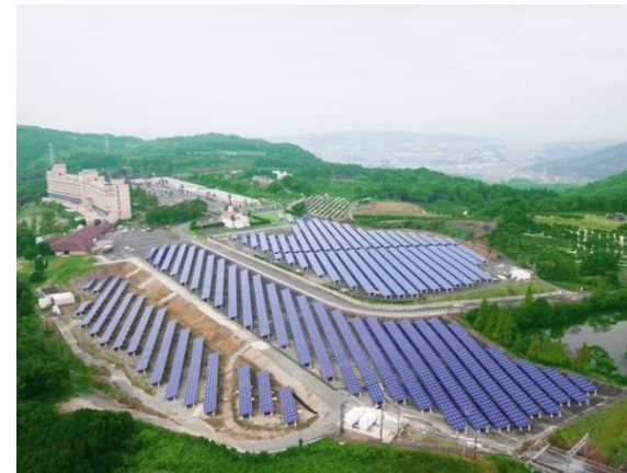
＜熊本県南関町 太陽光発電所＞
