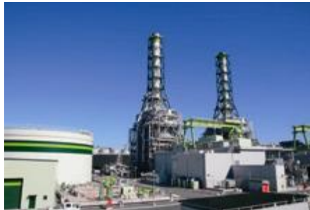
川崎天然ガス発電 (84万kW、49%出資)
