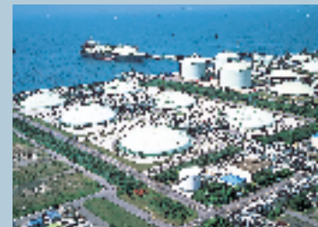
世界最大の袖ヶ浦LNG基地
