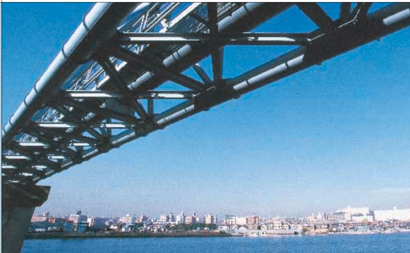
1999年12月の京浜幹線・横浜幹線の完成により、首都圏を取り巻く約300kmの環状幹線が完成しました。写真は京浜幹線の鶴見川橋。
