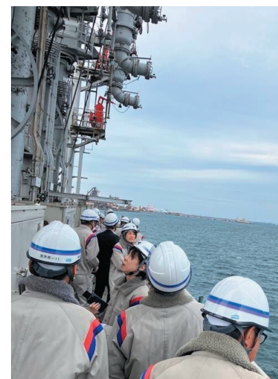
LNG船受入海上栈橋(扇島LNG基地)視察時の様子
