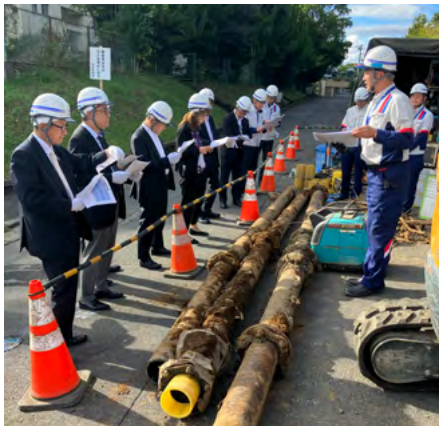
経年ガス管の取替工事 (東京ガスネットワーク)視察時の様子
