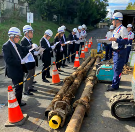
経年ガス管の取替工事 (東京ガスネットワーク)視察時の様子
