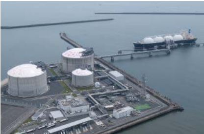
日立LNG基地
