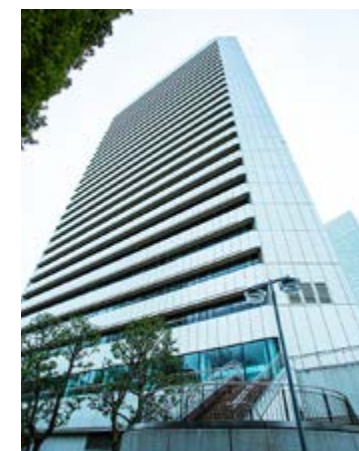
浜松町本社ビル
