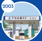
2003 水素ステーション
