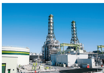
川崎天然ガス発電
