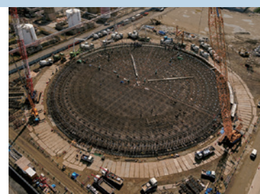
新居浜LNG基地
