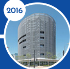
2016 豊洲スマートエネルギーセンター
