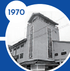
蔵前国技館 初的气体冷房システム
