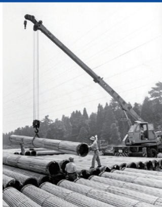
千葉幹線工事
