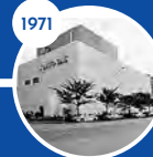
旧新宿地域 冷暖房センター
