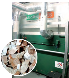
バイオマスボイラーと木質チップ
