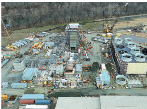
パースボロ発電所(建設中)
