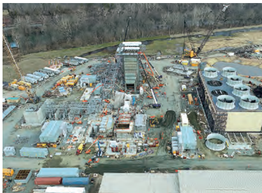
パースボロ発電所(建設中)
