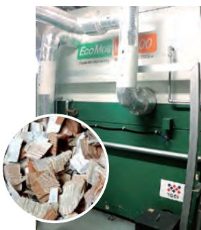
バイオマスボイラーと木質チップ
