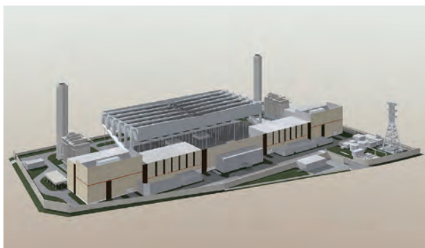
真岡発電所（完成イメージ）
