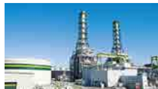
川崎天然ガス発電
