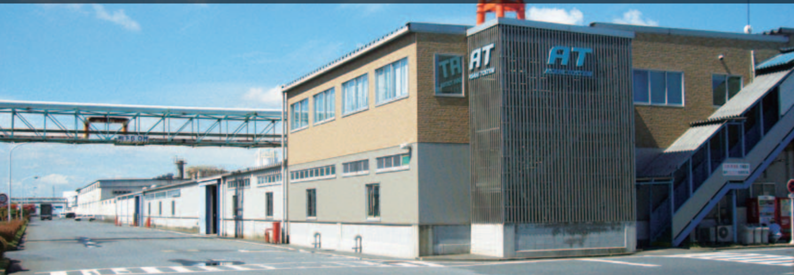
旭トステム外装(株)鹿島工場
