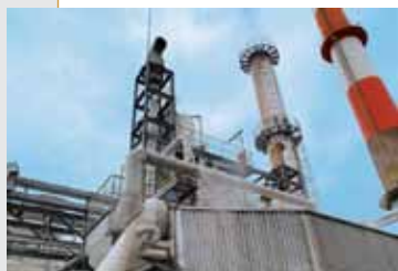
点火試験が完了した2号ボイラ
