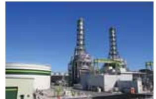
④ 川崎天然ガス発電
