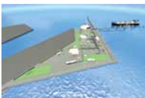
④ 日立LNG基地
