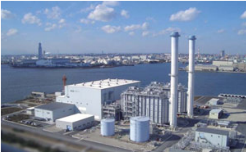
扇島パワーステーション1・2号機 (各出力40.71万kW)
