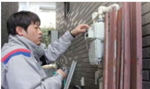
お客さま宅での復旧作業
