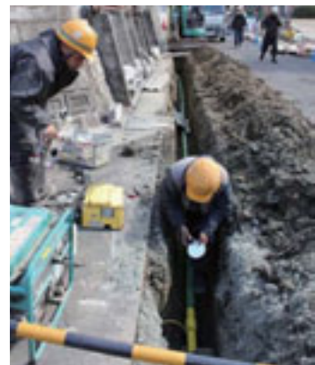
パイプライン復旧作業
