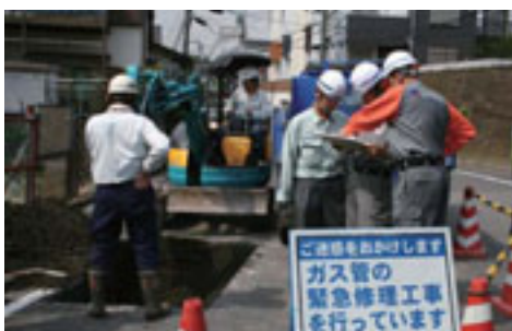
ガス管の緊急修理工事
