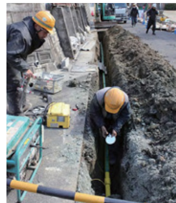
パイプライン復旧作業
