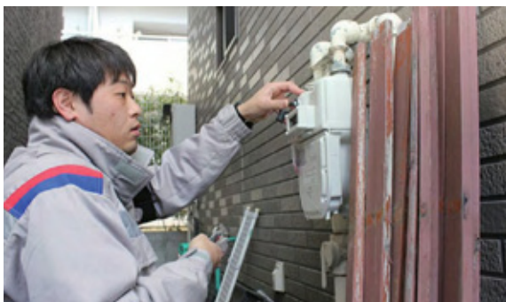
お客さま宅での復旧作業
