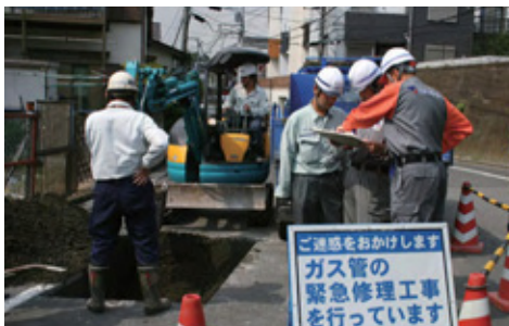
ガス管の緊急修理工事
