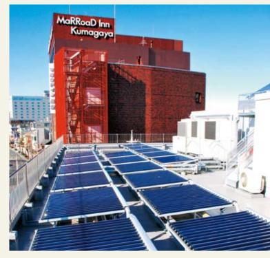
東京ガス熊谷支社における熱融通システム:東京ガス熊谷支社屋上に設置された太陽熱集熱器(写真手前)から得られる太陽熱を、隣接するホテル(写真奥)へ熱融通導管を利用して融通している。太陽熱を所有者の異なる民間建物間で熱融通するシステムとしては日本初。
