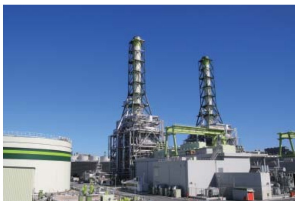
川崎天然ガス発電
