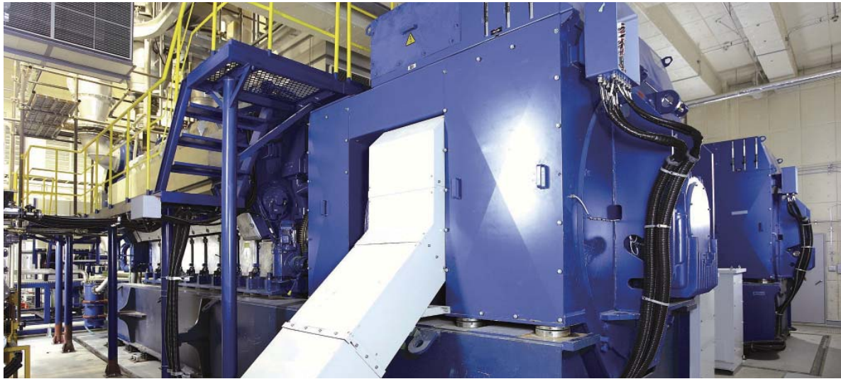
最新の高効率大型ガスエンジンによる天然ガスコージェネレーションシステム(幕張地域冷暖房センター)
