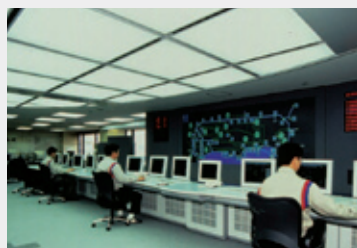
供給指令センター
