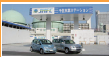
水素ステーション
