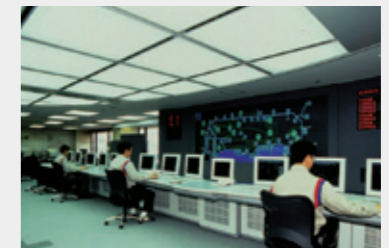
供給指令センター
