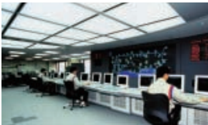
供給指令センター
