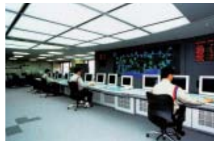
供給指令センター
