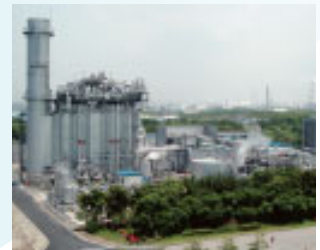
(株)東京ガスベイパワー発電所
