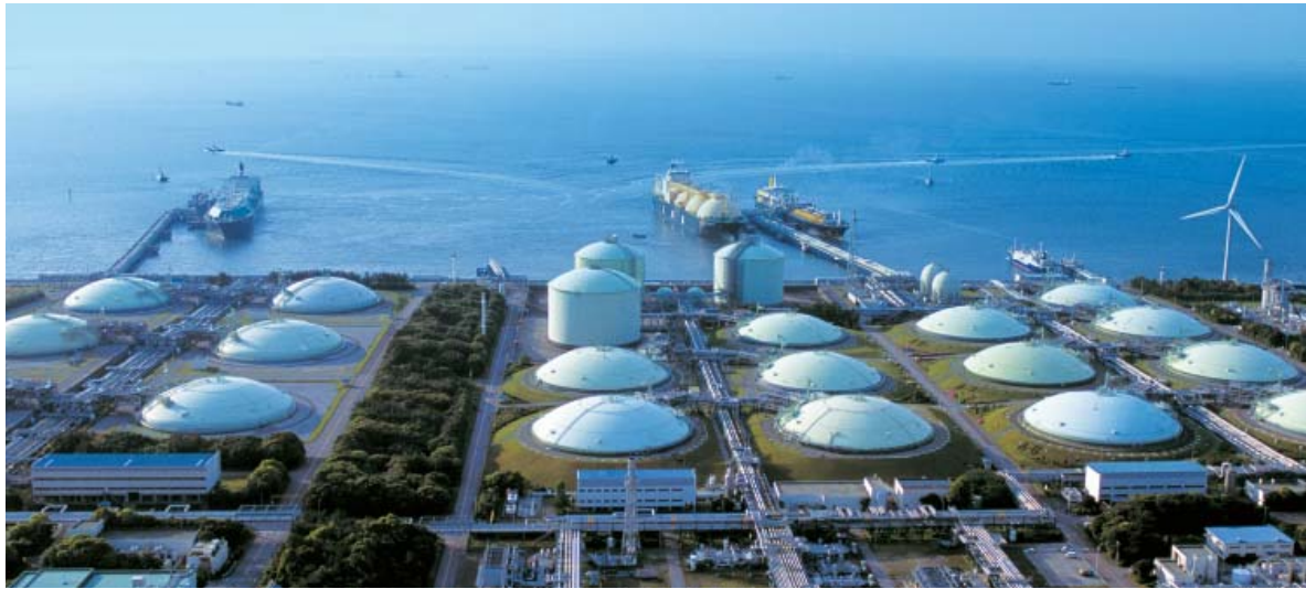
Tokyo Gas Sodegaura LNG Terminal
