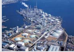
根岸LNG基地
