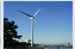
袖ヶ浦LNG基地内の風力発電設備
