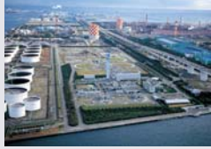
扇島LNG基地
