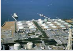
袖ヶ浦LNG基地
