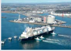
日立LNG基地
