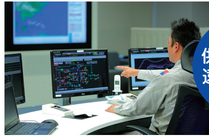
供給指令センター
