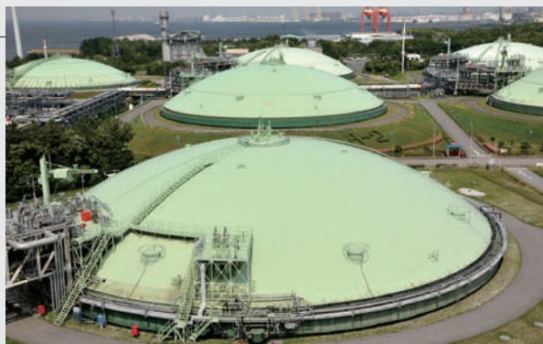
LNGタンク外観
