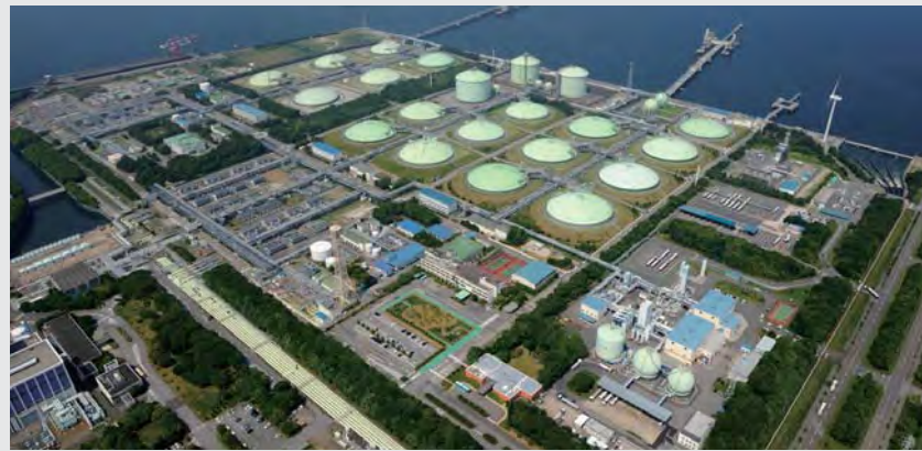
袖ヶ浦LNG基地
