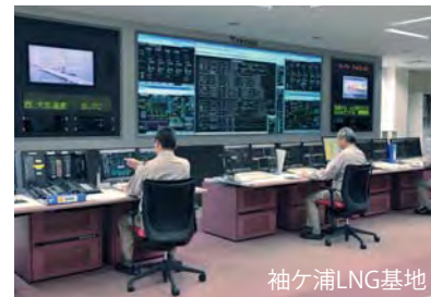
袖ヶ浦LNG基地
