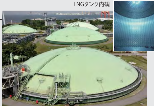
LNGタンク外観
