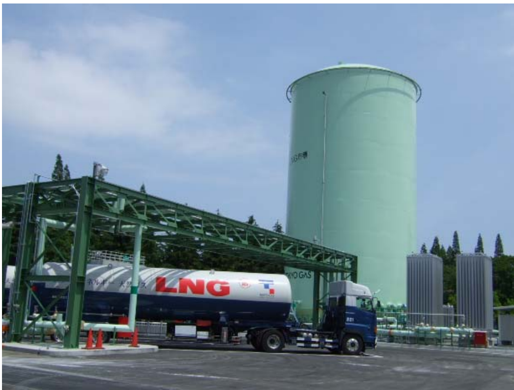
LNG lorry and storage tank
