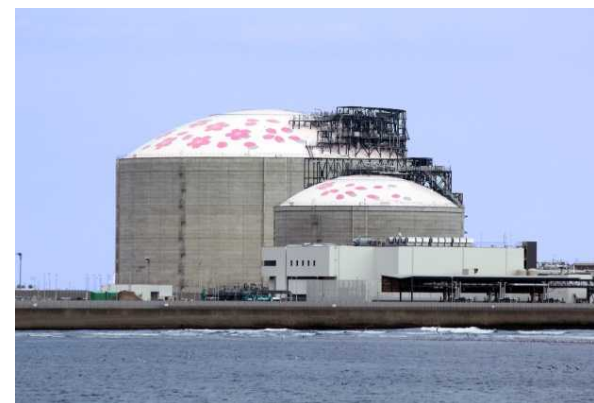
写真：日立LNG基地
