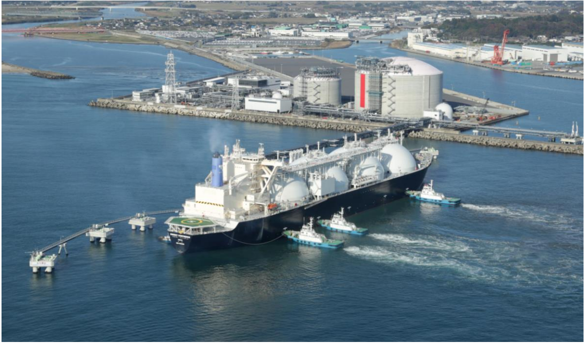
日立LNG基地
